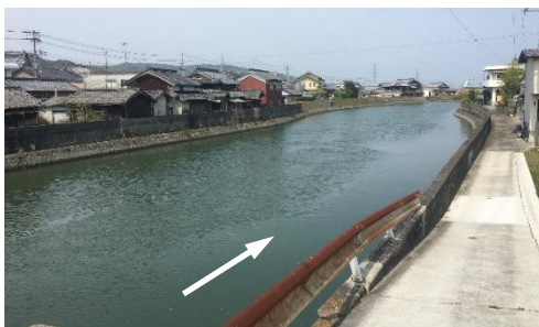
大日川 河川改修(南あわじ市)
