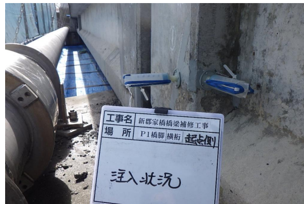
新郡家橋 橋桁補修(淡路市 R6完)
