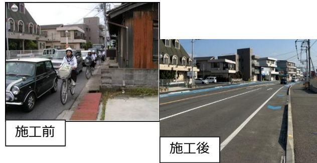
福良江井岩屋線 歩道整備（南あわじ市湊～松帆古津路）
