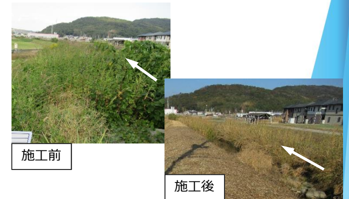
鮎屋川 堤防の点検前除草（洲本市）
