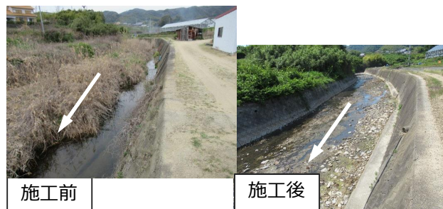
生穂川 堆積土砂撤去(淡路市 R5完)
