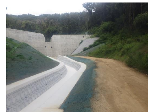
安坂北谷川 砂防えん堤整備(洲本市 R6完予定)
