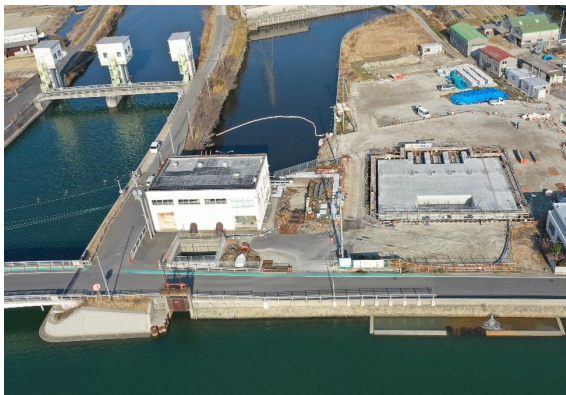
倭文川排水機場 更新(南あわじ市)
