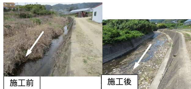
生穂川 堆積土砂撤去(淡路市 R5完)
