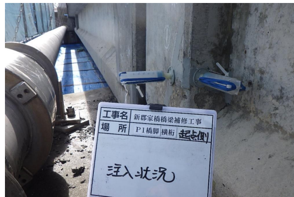
新郡家橋 橋桁補修(淡路市 R6完)
