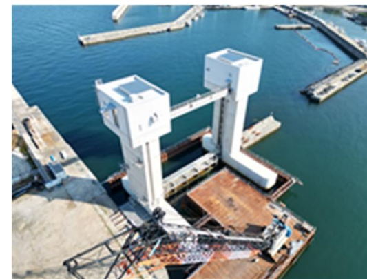
沼島漁港本港地区港口水門（R6.2完成）
