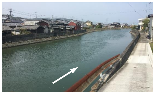
大日川 河川改修(南あわじ市)
