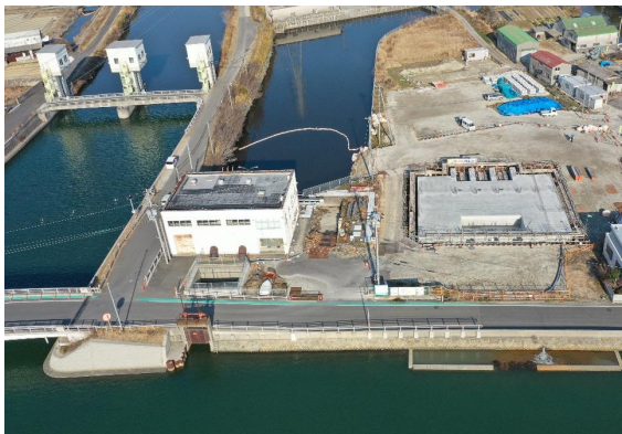
倭文川排水機場 更新(南あわじ市)
