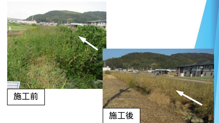
鮎屋川 堤防の点検前除草（洲本市）
