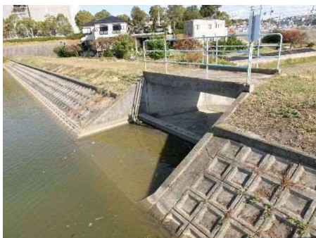
洪水吐(上流側)
