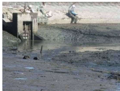
泥土除去後の状況(かいぼり実施後)
