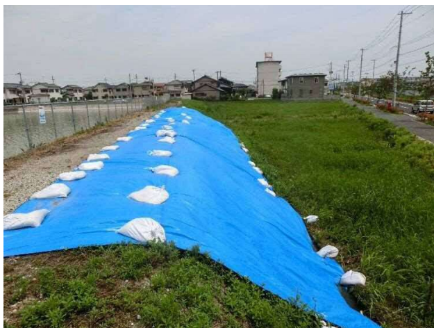
堤体下流法面にブルーシート設置
