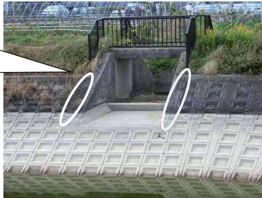
洪水吐(貯水池側より)
