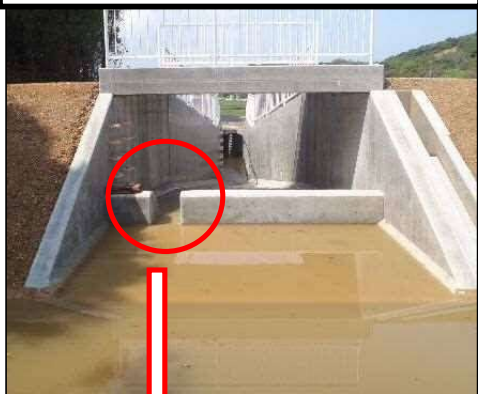
【南あわじ市 洪水吐越流堰の切欠き】
