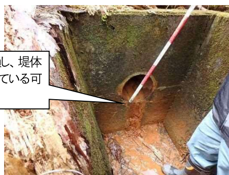
底樋出口(堤体下流)
