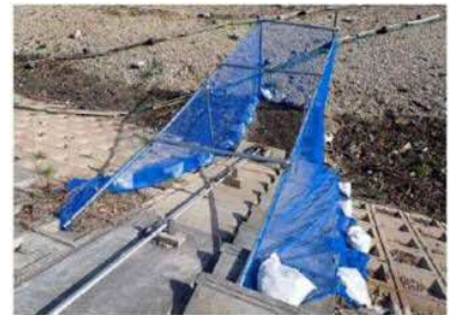
取水施設周りに防風ネットを設置
