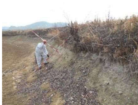
堤体の浸食状況等の点検
