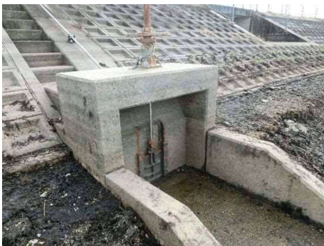
土砂吐ゲート部 腐食及びクラック等の点検
