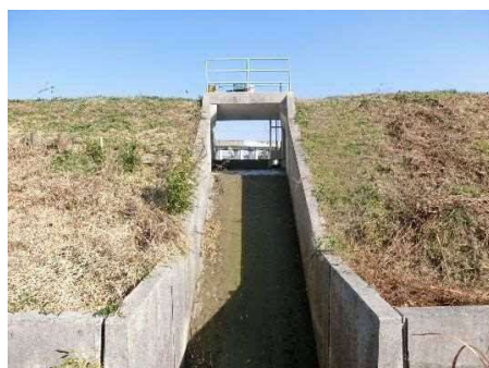
洪水吐(下流側)
