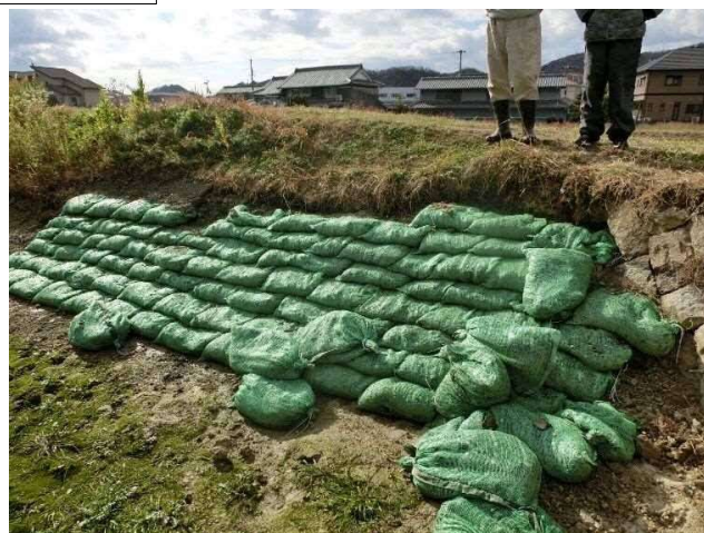
堤体上流法面に土のう設置
