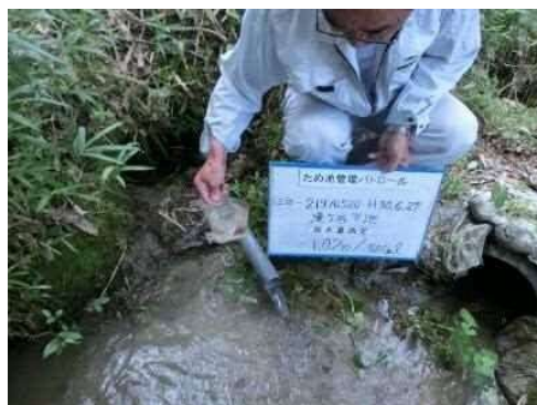
後法 漏水量測定(遠景)
