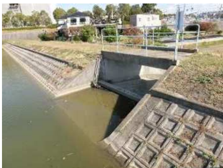
洪水吐(上流側)
