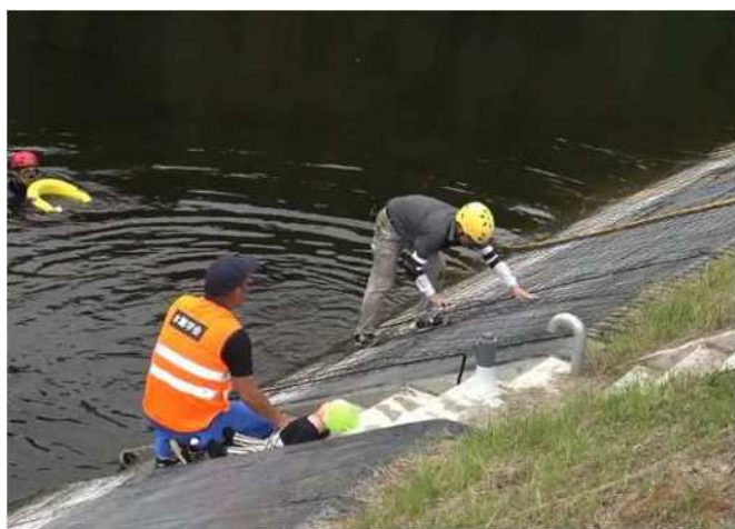
法面にネットの設置
