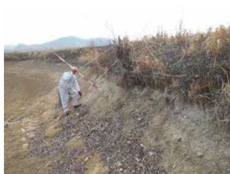
堤体の浸食状況等の点検
