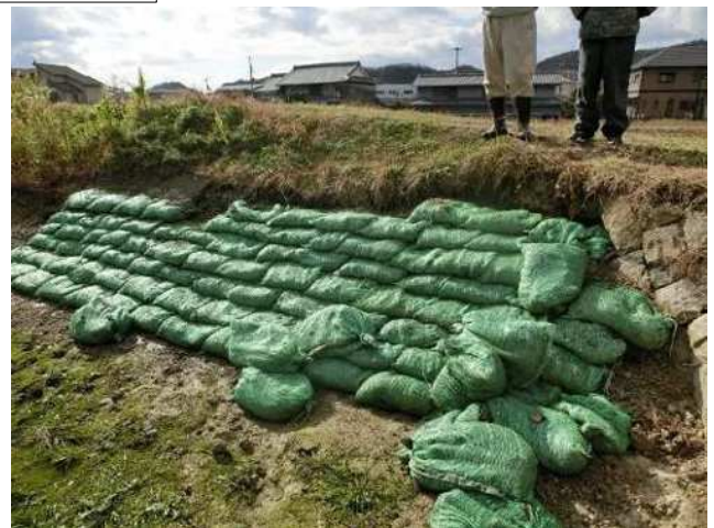
堤体上流法面に土のう設置
