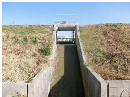
洪水吐(下流側)
