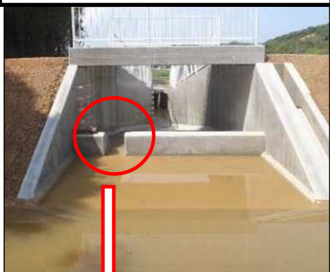
【南あわじ市 洪水吐越流堰の切欠き】
