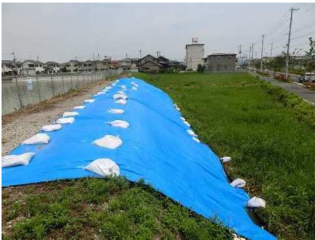
堤体下流法面にブルーシート設置
