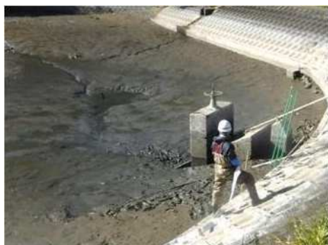
泥土堆積状況(かいぼり実施前)
