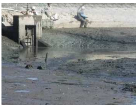
泥土除去後の状況(かいぼり実施後)
