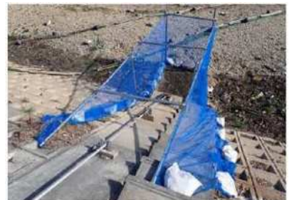
取水施設周りに防風ネットを設置
