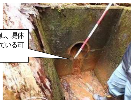
底樋出口(堤体下流)
