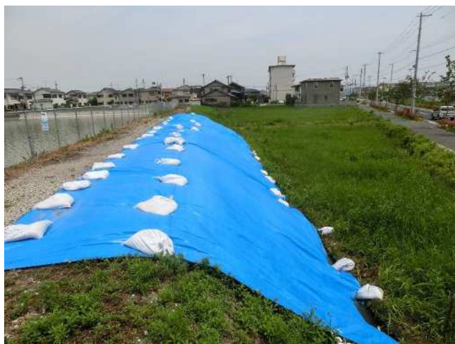
堤体下流法面にブルーシート設置
