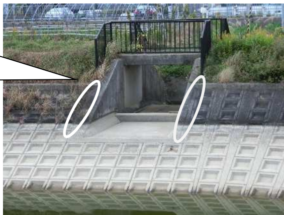
洪水吐(貯水池側より)
