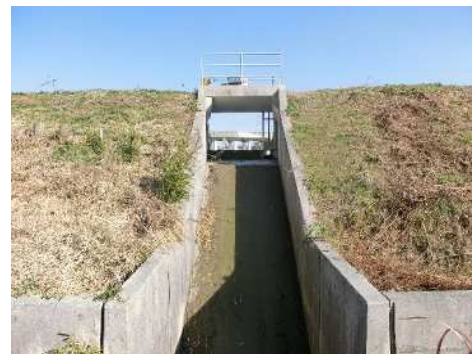
洪水吐(下流側)
