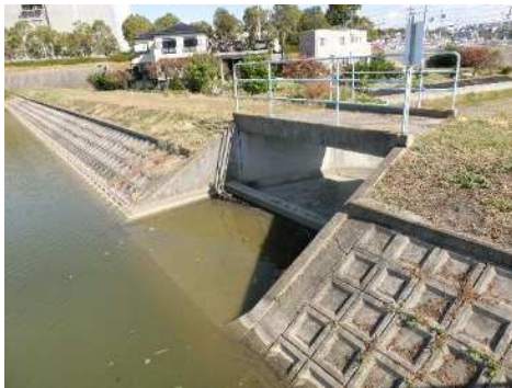
洪水吐(上流側)
