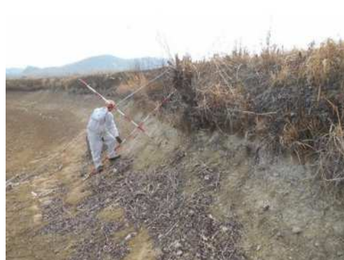
堤体の浸食状況等の点検
