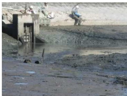
泥土除去後の状況(かいぼり実施後)
