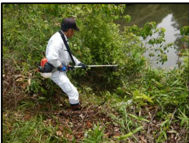
ため池前法での草刈作業の様子
