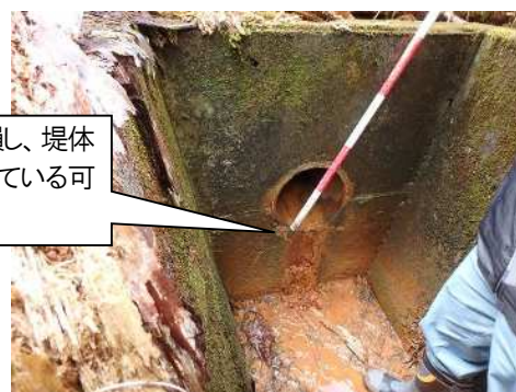
底樋出口(堤体下流)
