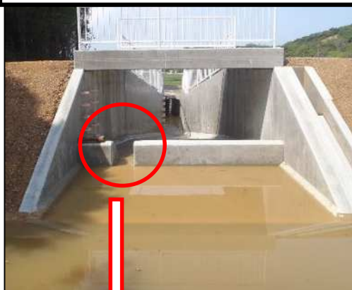
【南あわじ市 洪水吐越流堰の切欠き】
