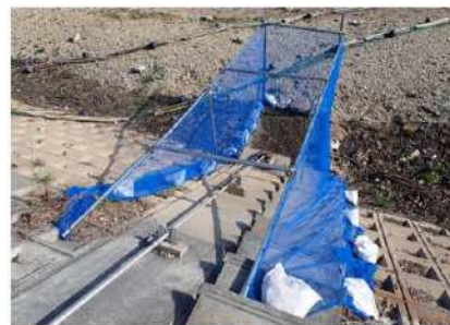
取水施設周りに防風ネットを設置
