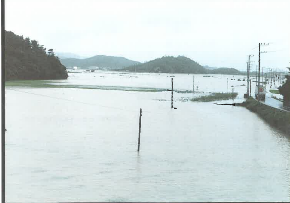
防災区域における湛水状況
