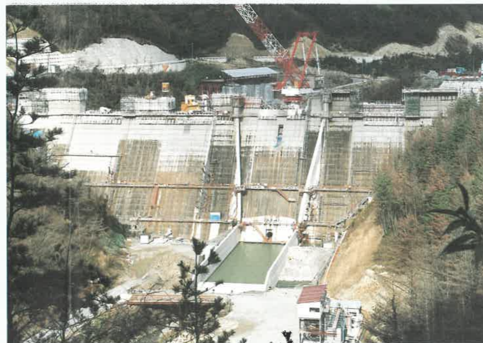
本庄川ダム施工状況 (平成4年12月末)
