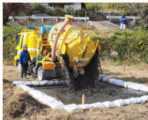
バキュームカーによる乾燥場への投入・ストック
