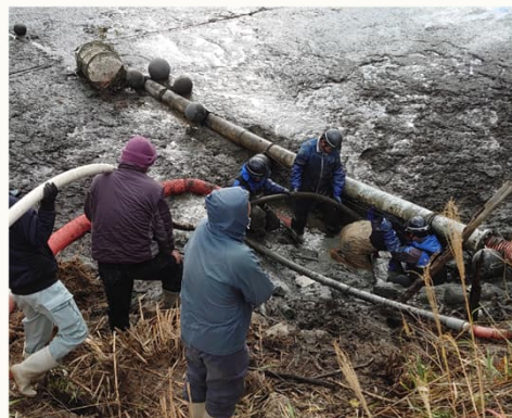
泥を吸い上げつつ進める、底樋の手探り探索
