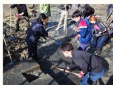
底樋前の泥かき出し
