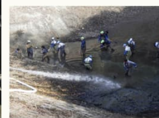
攪拌による濃い泥水づくり
