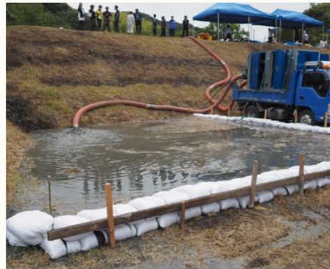
ポンプで吸い上げた泥を一時貯留
