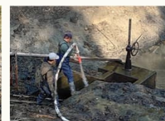
斜樋を仕上げ洗い
