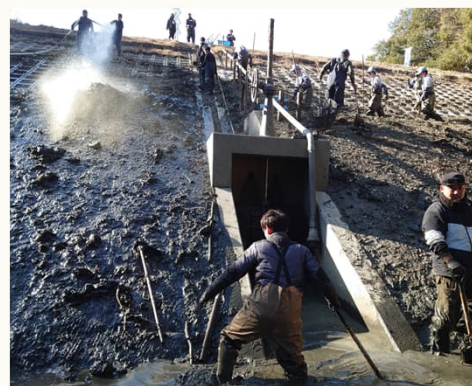
かいぼり後の仕上げに、法面清掃と道具の片付け
