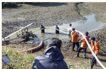
底樋のつまりを水压で解消
