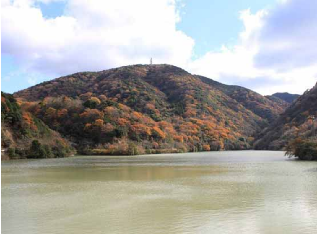
初尾川ダム 全景
