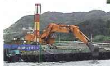
(1) バックホウ浚渫船による洲本川の浚渫
