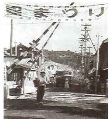
昭和35年、塩屋筋の踏切に自動運搬機が設置された(写真提供: 宗 虎男氏)
