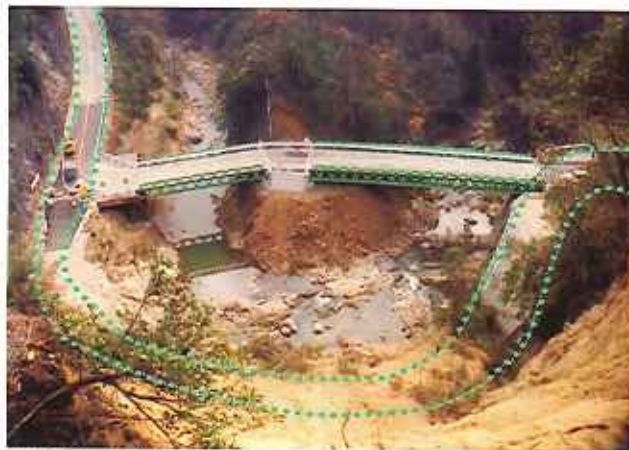
土砂崩落箇所を避けるように架設した2本の仮橋
