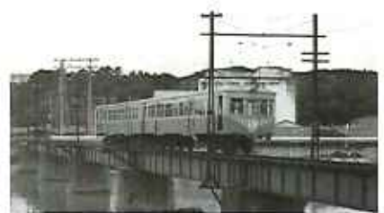
洲本川鉄橋 上層工が7径間の単線鉄橋(単線)だった。下層工が石橋構造でできていた。(写真提供: 森忠夫氏)
