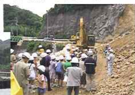
(2) 県道洲本五色線が原で直取土砂を搬送する(ワーシャベル)(五色町地区)
