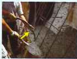
バイブレーター
