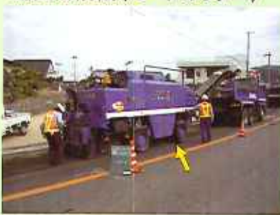
路面切削機(ロードカッター)
