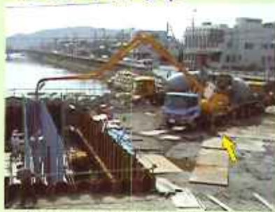
コンクリートポンプ車
