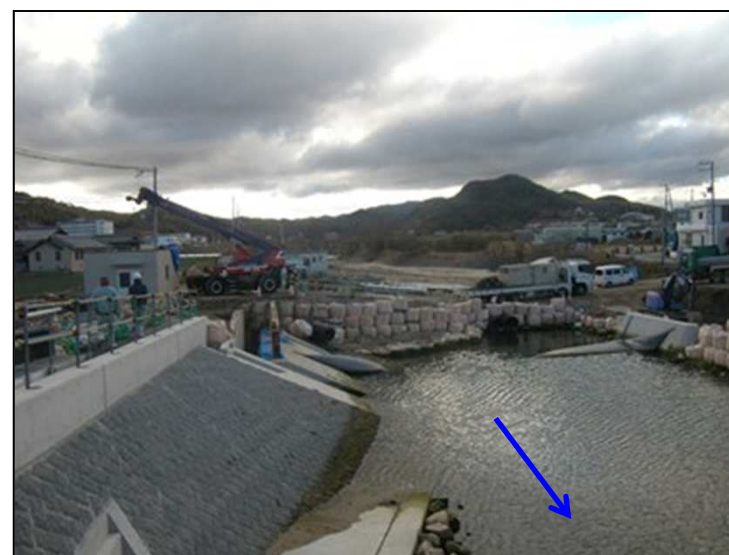
【都志川水系 都志川潮止堰設置】
