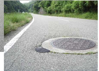
舗装損傷箇所の応急対策
