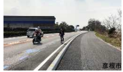
路肩拡幅の整備例
