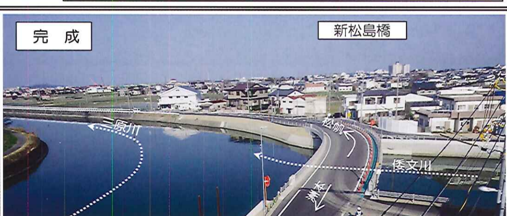
倭文川下流部の狭小部が広がり、橋脚の無い1スパン橋となって流況の乱れも水あたりによる水位の上昇も無くなり、安全なスムーズな流れになったね!
