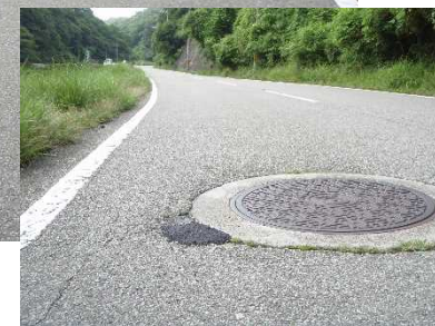
舗装損傷箇所の応急対策
