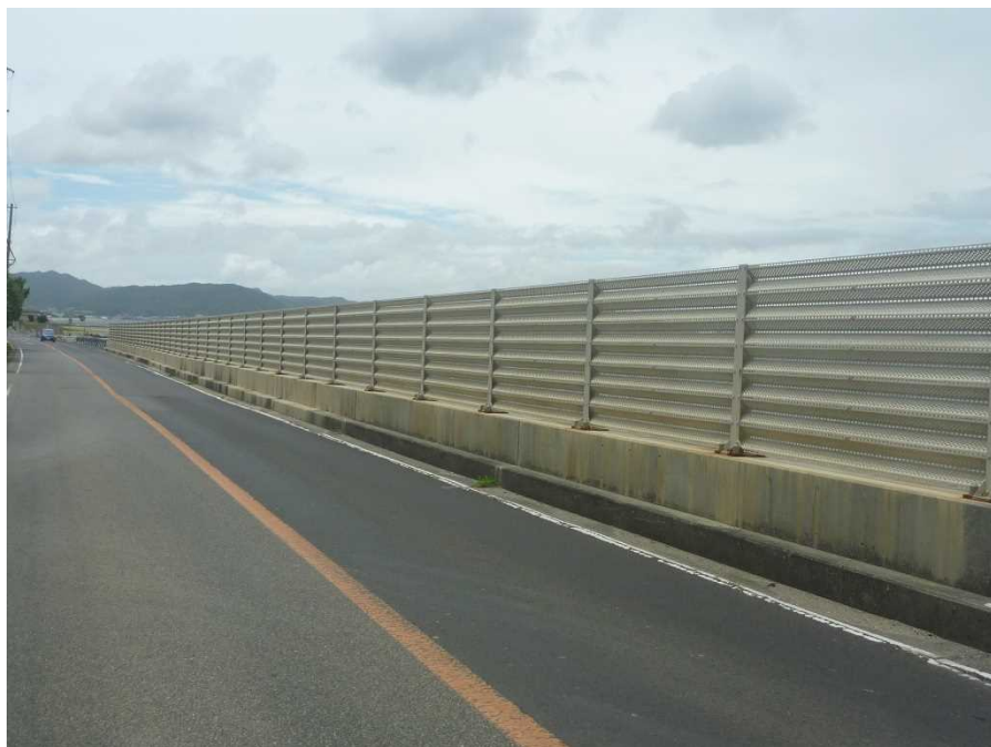
越波防止フェンス設置
