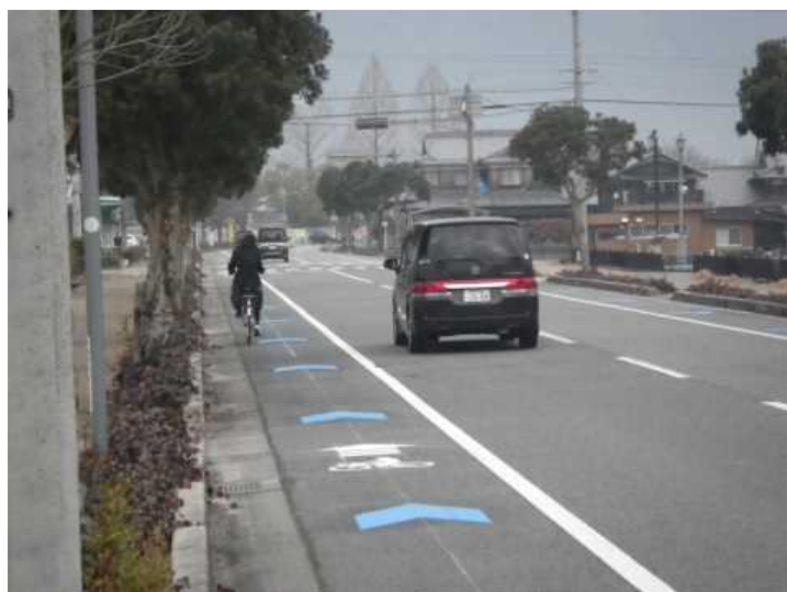
矢羽根型路面表示の整備事例 [県道多可柏原線(多可町)]
