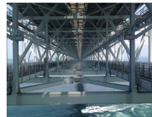
大鳴門橋桁下空間(現況)
