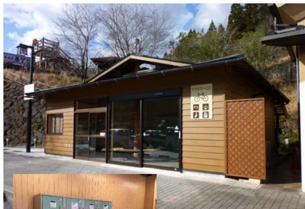
休憩施設外観
