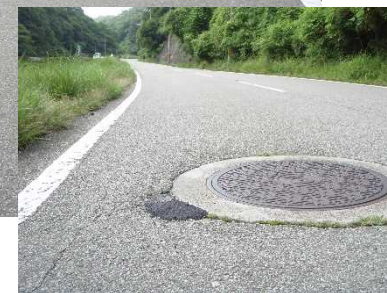
舗装損傷箇所の応急対策
