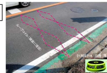
観測機器の設置状況
