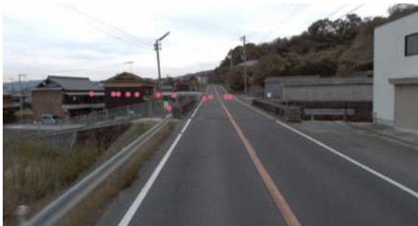
(主)31号 福良江井岩屋線 (淡路市育波) (歩道なし、路肩0.5m)
