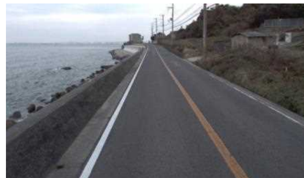
(主)31号 福良江岩屋線 (淡路市野島江崎) (沿岸部、歩道なし、路肩0.5m)
