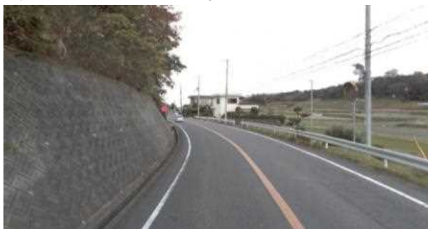
(主)31号 福良江岩屋線(洲本市五色町都志) (歩道なし、路肩0.75m)
