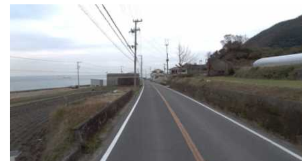
(主) 31号 福良江岩屋線 (淡路市江井) (沿岸部、歩道なし、路肩0.5m)
