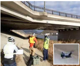
橋梁点検(ドローン撮影)
