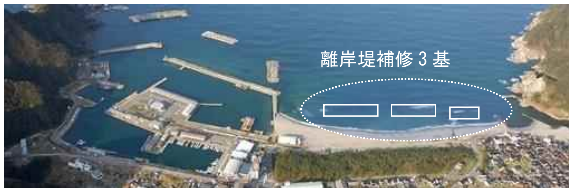
漁港海岸離岸堤補修
