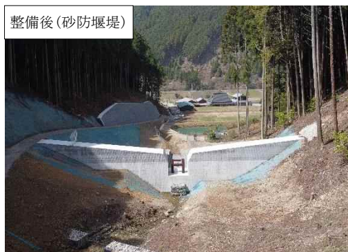
土石流防止対策
