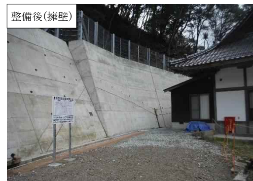
崖崩れ防止対策
