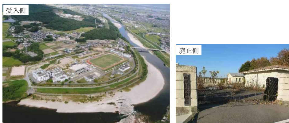
下水処理施設の広域化・共同化
