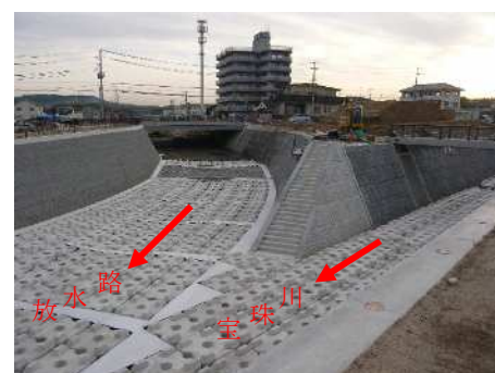
志筑川放水路と 宝珠川の合流部
