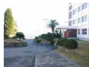
東浦中学校校舎 玄関口
