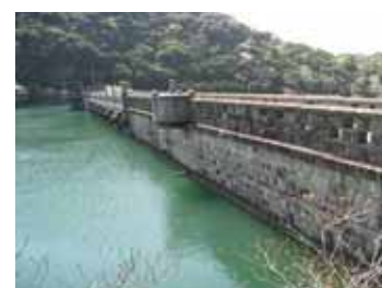
山側から見た石積み式堤体
