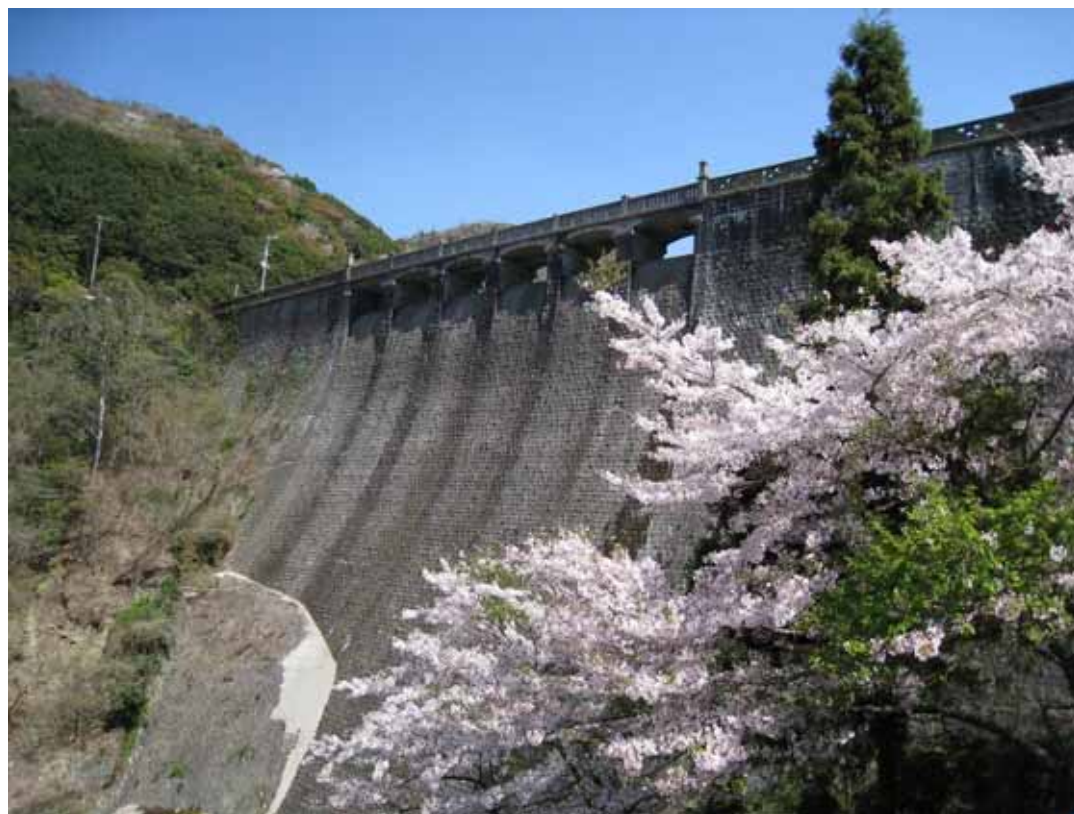
桜と石積み式堤体
