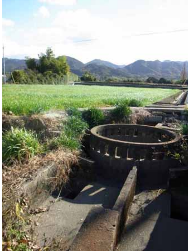
用水路の円筒分水工
