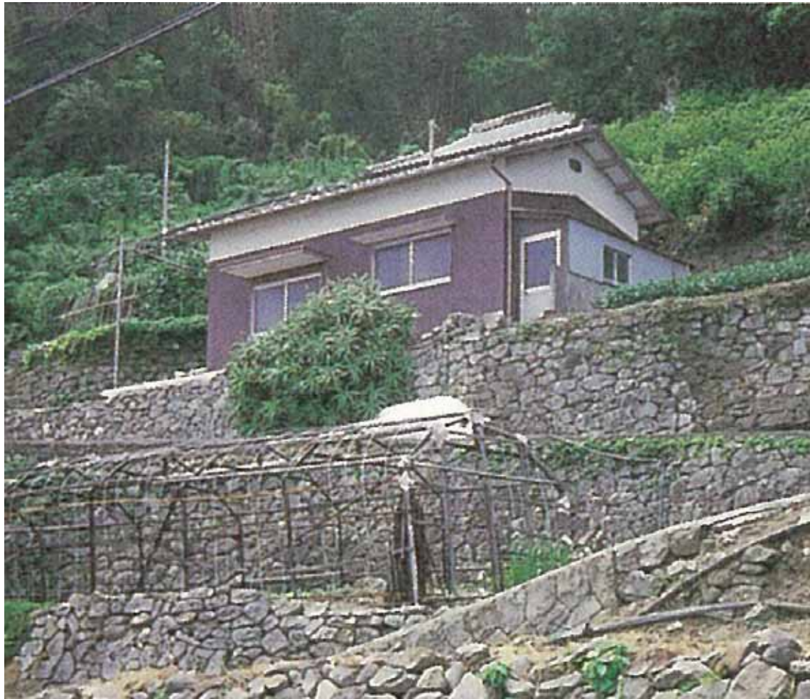
灘地区 石積みの擁壁 出典：兵庫県資料
