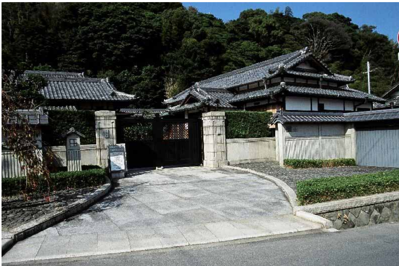
春陽荘の母屋と門塀 出典：淡路島まるごとミュージアムHP
