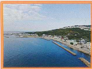
(木場) 西淡海岸 離岸堤改良工事
