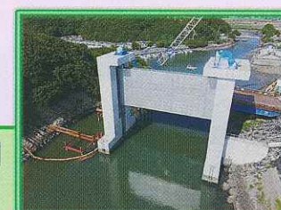
(阿万塩屋町) 本庄川・塩屋川 津波対策(水門設置)工事
