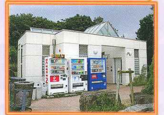
(岩屋) 淡路島公園 トイレ改修工事 遊具改修工事
