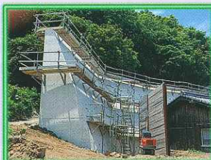
(阿那賀) 県道阿万福良湊線 桜谷橋橋梁補修工事
