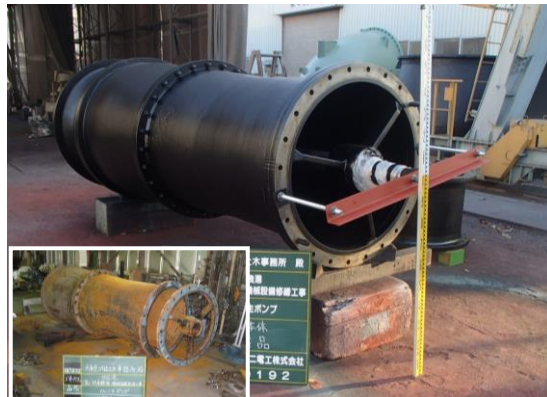
由良港第二排水機場(ポンプの修繕)
