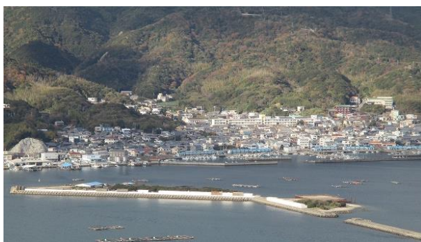
福良港 湾口防波堤
