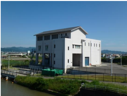
入貫川排水機場
