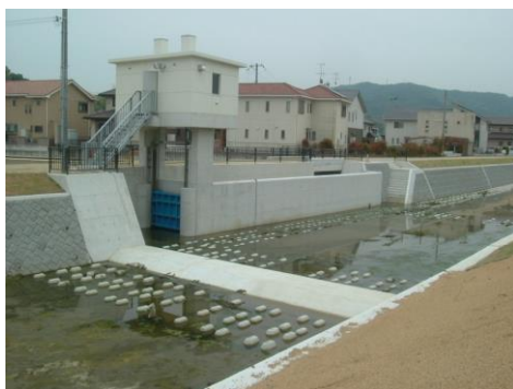
志筑川 放水路
