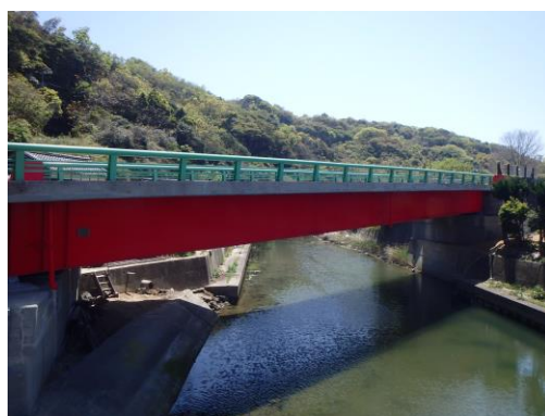
福良江井岩屋線(明神橋)
