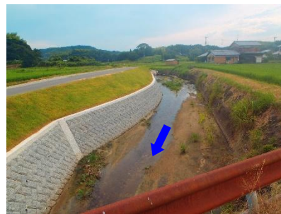
志筑川中上流部(中道橋周辺)
