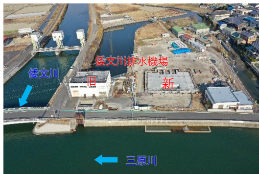
倭文川排水機場
