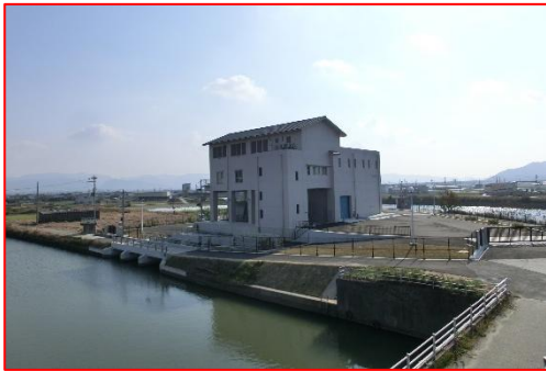
入貫川排水機場 (6.6m 3 /s→16.8m 3 /s 増強完了) 孫太川排水機場 (7.5m 3 /s 更新完了)
