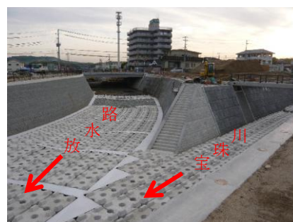
志筑川放水路と 宝珠川の合流部
