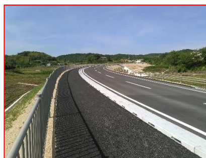
歩道部の透水性舗装（県道洲本五色線 洲本市）
