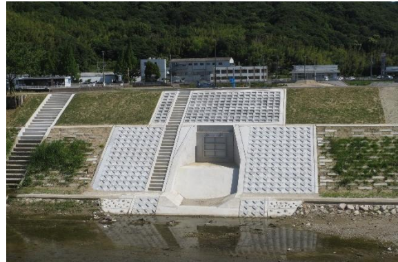
桑間第3雨水幹線（洲本市）
