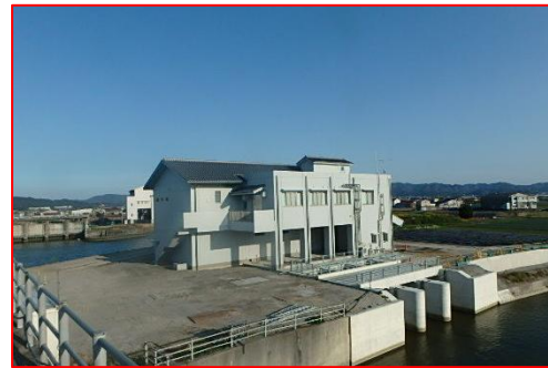
入貫川排水機場 (6.6m 3 /s→16.8m 3 /s 増強完了) 孫太川排水機場 (7.5m 3 /s 更新完了)
