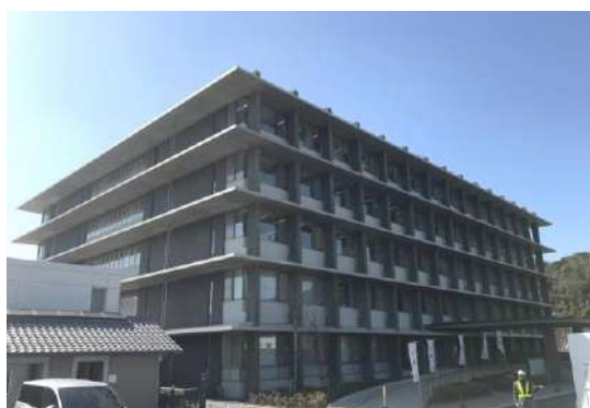
図 48 洲本総合庁舎の建物嵩上げ
