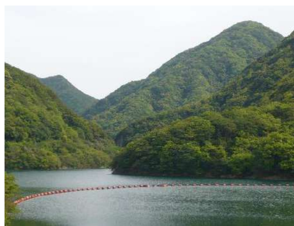
鮎屋川ダム貯水池（洲本市）
