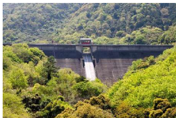
鮎屋川ダム（洲本市）
