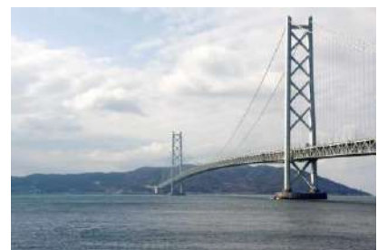
明石海峡大橋
