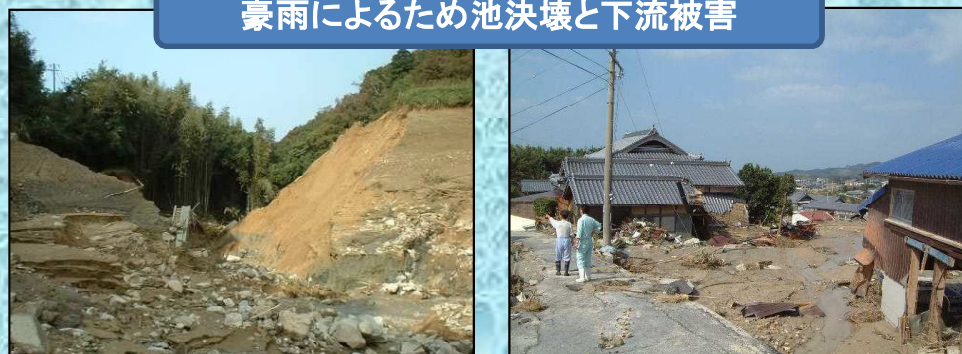
豪雨によるため池決壊と下流被害
