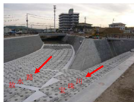
志筑川放水路と 宝珠川の合流部
