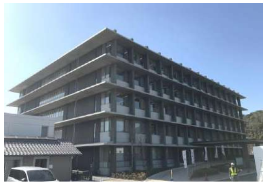
図 48 洲本総合庁舎の建物嵩上げ
