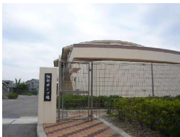
物部ポンプ場（洲本市）
