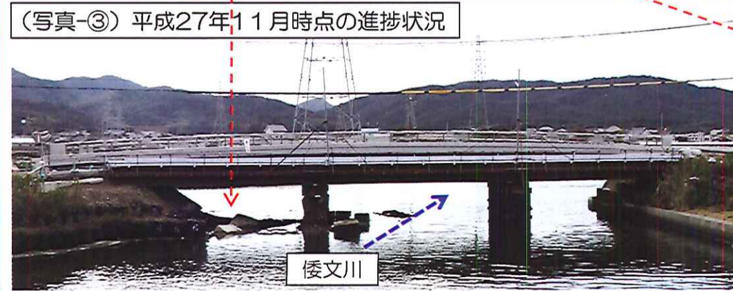
着手前 橋の架替の進捗により、倭文川の三原川への流下能力が向上している。
