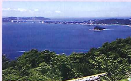
新たなランドマークとなっている 大鳴門橋
