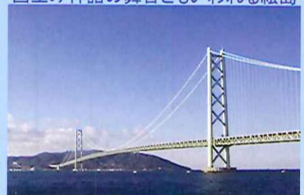
明石海峡大橋
