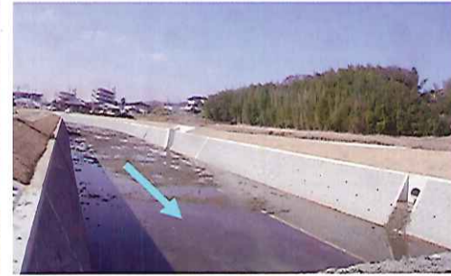
工事が進む志筑川放水路
