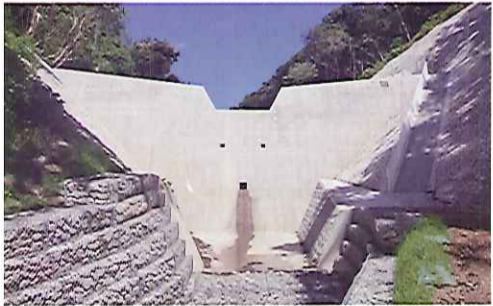
(砂) 岩戸台谷川 砂防堰堤完成
