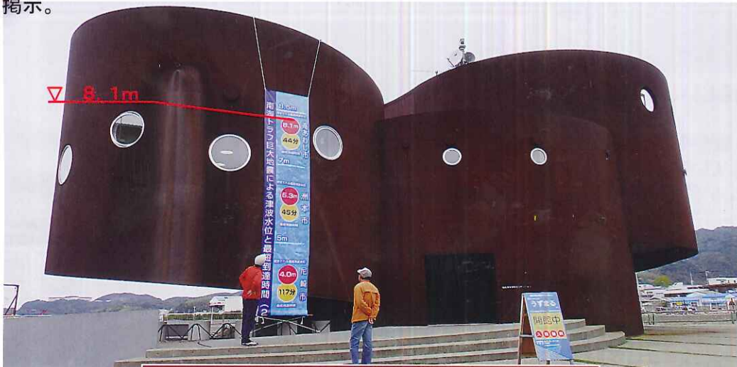
福良港津波防災ステーション 垂れ幕設置状況
