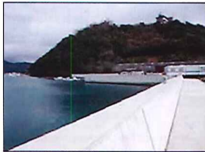
【防潮堤整備(福良港)】
