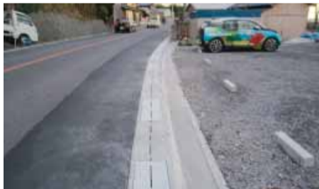
側溝の蓋掛けによる路肩拡幅(淡路市野島)
