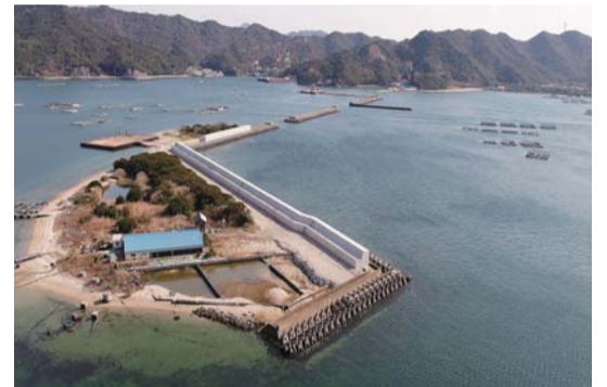
福良港(湾口防波堤整備)
