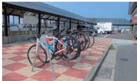
サイクルラックの設置(岩屋港)
