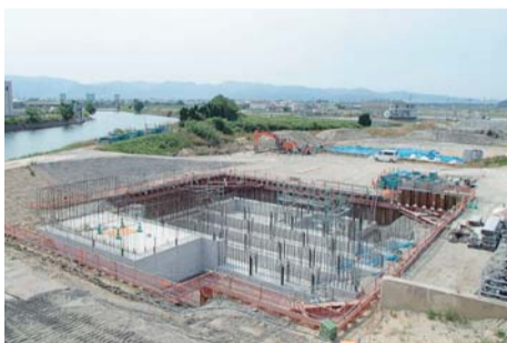
孫太川排水機場工事(湊、松帆西路地区)
