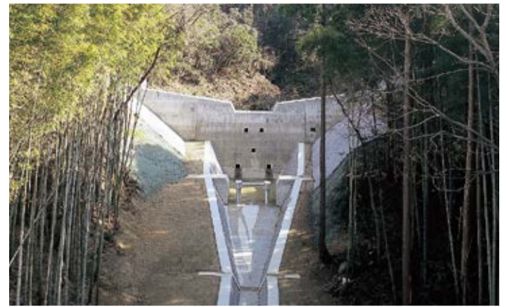
完成した三野畑北谷川砂防ダム
