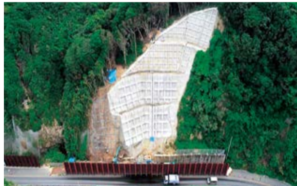
工事進捗状況
