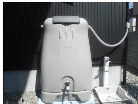
雨水貯留タンク設置の事例(洲本市)
