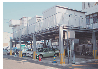
自家発電設備の高層階設置 (淡路県民局)
