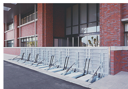
県立淡路医療センターの浸水防止壁
