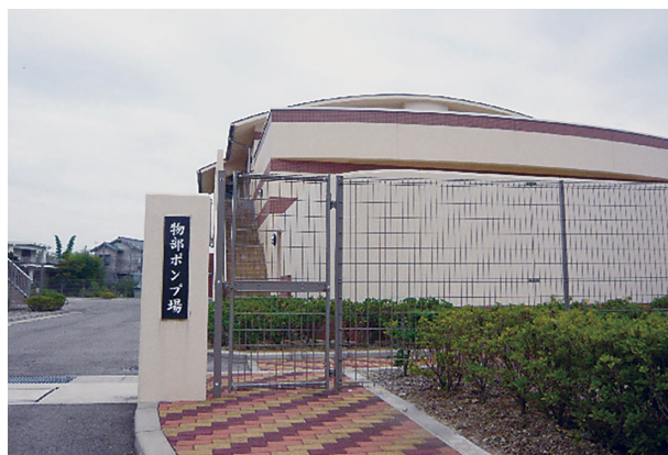
物部ポンプ場
