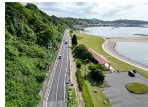
県道福良江井岩屋線 路肩拡幅 淡路市多賀
