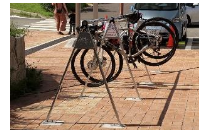
サイクルラック整備状況 (道の駅あわじ)
