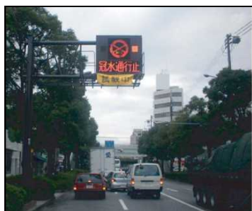
冠水情報板の設置
