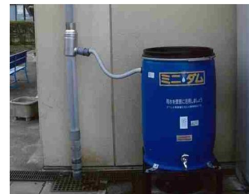
※大雨の前に放流することが雨水の流出抑制を図る上で有効です。
