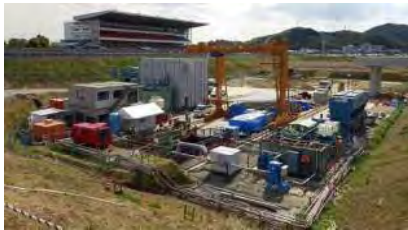
導水路工事仮設備状況
