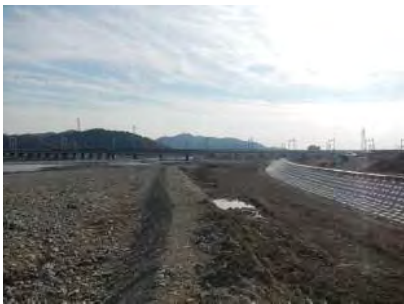
二級河川 市川《JR橋梁工区》 護岸・掘削<平成29年度完成>
