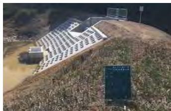
洪水吐・オリフィス樹 (堤体樹裏法面)
