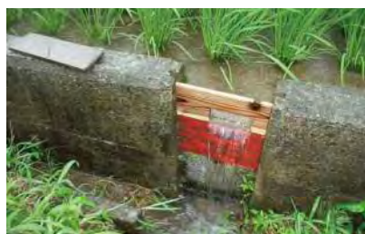
福崎町 たんぼダム堰板配布 (福崎町板坂地区)
