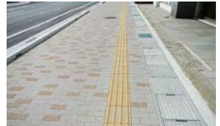
兵庫県 道路浸透側溝 (一)姫路停車場線(姫路市平野町)
