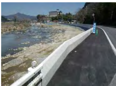
二級河川 夢前川《夢前町古知之庄》 平成28年度中上流部治水安全度向上対策事業
