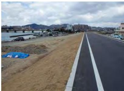
二級河川 水尾川《下流工区》 護岸・掘削
