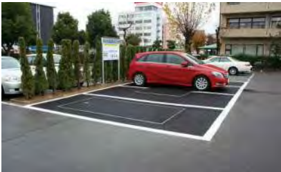
兵庫県 姫路庁舎浸透舗装実験 A=4.5 m 2 (姫路市北条1-98)
