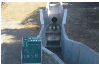
洪水吐・放流管 (堤体正面)
