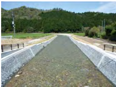
二級河川 振古川《上流工区》 護岸・橋梁他<平成27年度完成>
