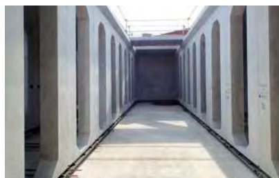
姫路市 地下貯留施設 V=700 m 3 (姫路市香寺町溝口)
