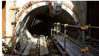
導水路坑口状況
