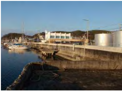
二級河川 八家川《木場～八家》 護岸・掘削<平成29年度完了予定>
