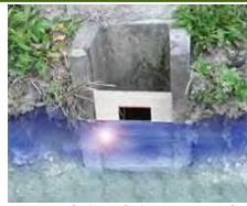
水田貯留 貯留用せき板
