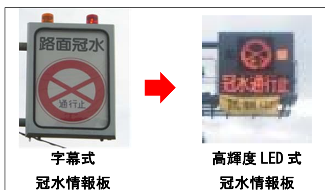
冠水情報板の高輝度 LED 式化
