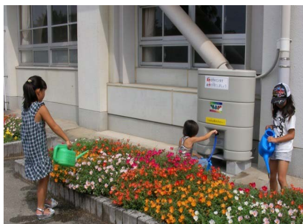
姫路市の小学校に設置されている雨水タンク
