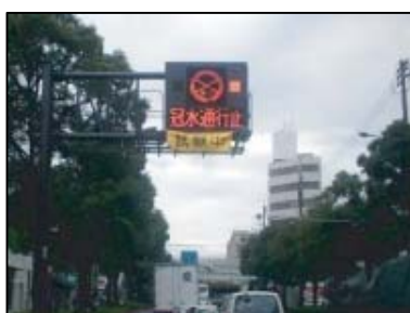
冠水情報板の設置
