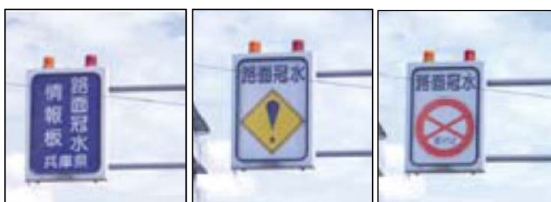
冠水対策用表示板の設置（注意喚起看板）
