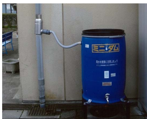
雨水貯留浸透（各戸）
