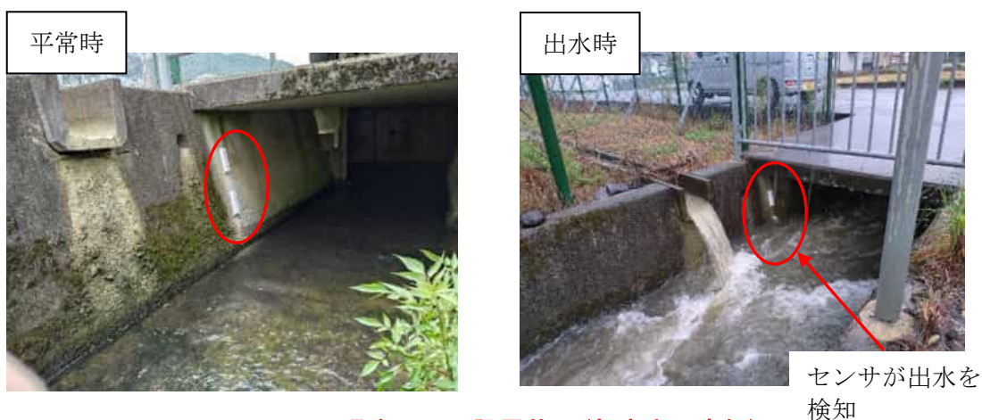
ワンコイン浸水センサ設置状況(朝来市の事例)
