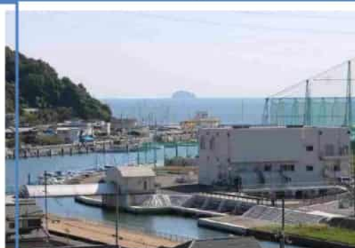
八家川排水機場
