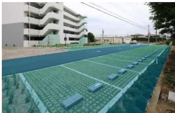
県営住宅(姫路御国野・御着住宅)の 駐車場貯留
