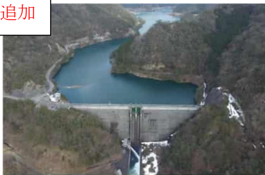
生野ダム (出典：「ひょうごのダム」パンフレット2)
