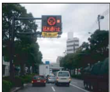
冠水情報板の設置
