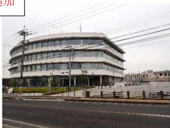
市役所新庁舎を盛土嵩上げ (高砂市)
