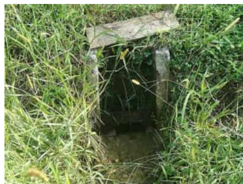
水田貯留の例（兵庫県市川町浅野区「田んぼダム」）
