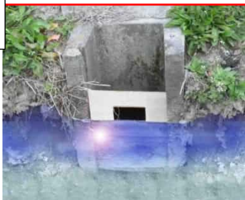
田んぼダム雨水貯留用せき板設置イメージ
