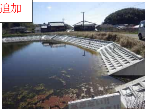
姫路市ため池整備例(新池)
