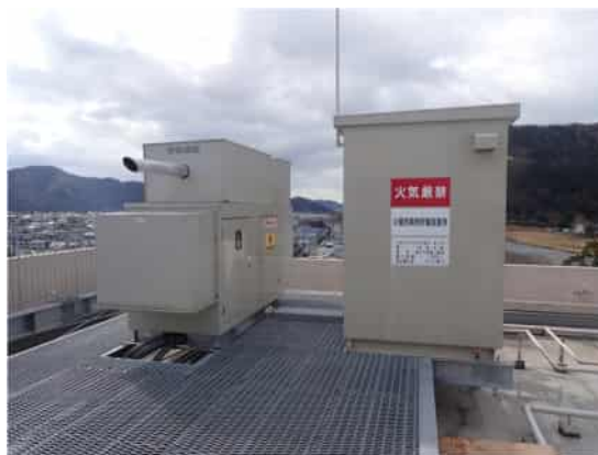
電気設備を庁舎屋上へ設置 (市川町)
