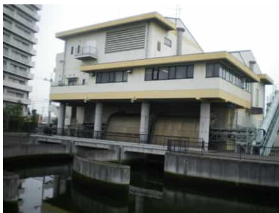
野田川排水機場
