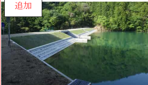
兵庫県ため池整備例(ジャク池)
