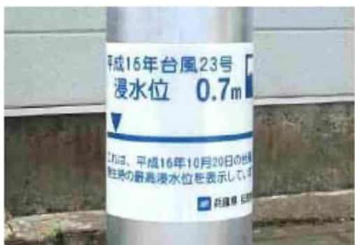
実績浸水深表示板 城崎総合地所
