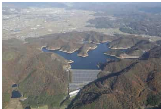
神谷ダム (出典：兵庫県企業庁より)
