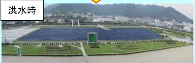
大雨時に船場川の洪水を貯留するとき
