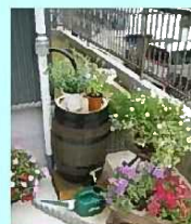
個人宅に設置された雨水タンク
