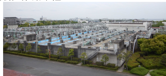
揖保川浄化センター(姫路市網干区)
