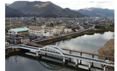
(二) 市川に架かる屋形橋（市川町）
