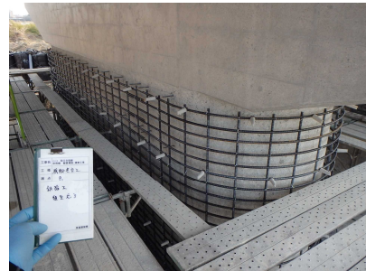
(一)和久今宿線 京見橋 橋脚巻立状況
