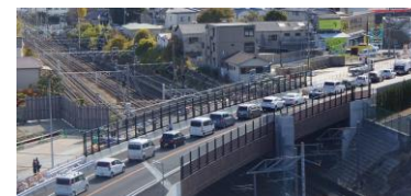
国道2号(和坂拡幅)の整備
