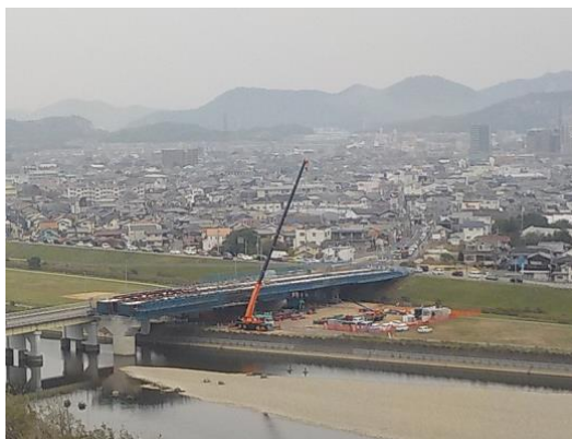
国道2号(加古川橋工区)の整備
