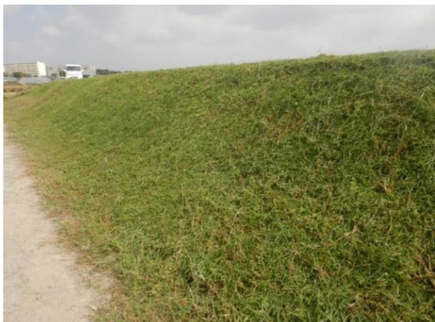
ため池の防災・減災対策の基本となる「管理者による適切な保全管理」の促進に向けて、大きな負担となっている法面の草刈り作業を省力化するため、グランドカバープランツによる被覆工法の導入実証を行います。
