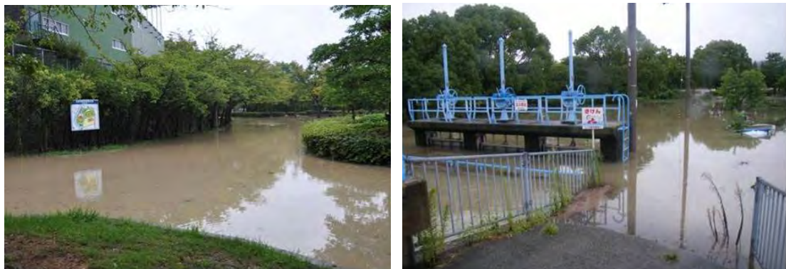
間の川の出水状況写真
