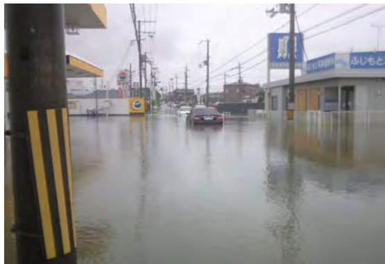
県道 小原宝殿停車場線の出水状況写真
